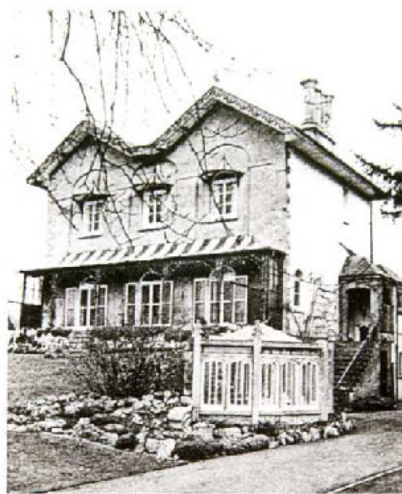
Casa para onde Eça foi morar após o casamento, em Stoke Bishop, na periferia de Bristol. Aqui residiu entre 1886 e 1888
