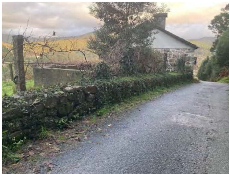
Rua e muro de vedação (1)
