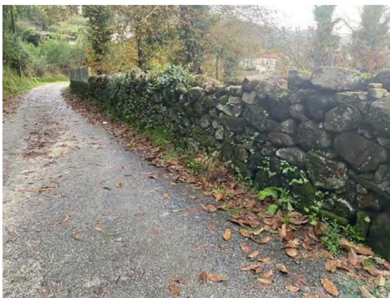
Rua e muro de vedação (2)
