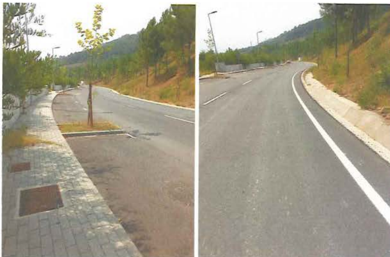
Fotos supra: Vistas do arruamento (rua do Penedo do Urso) a nascente do loteamento
