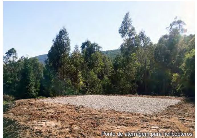
Ponto de aterragem para helicópteros
