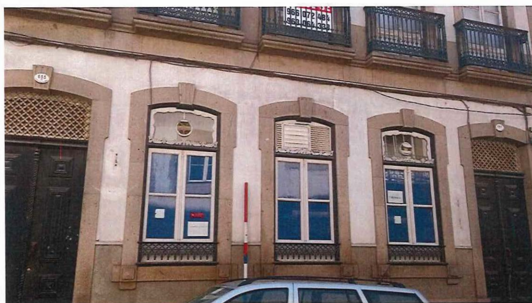
O edifício está em obras
