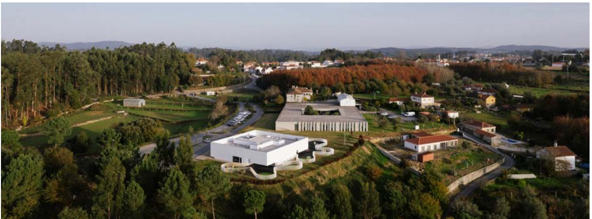
Vista aérea poente/nascente
