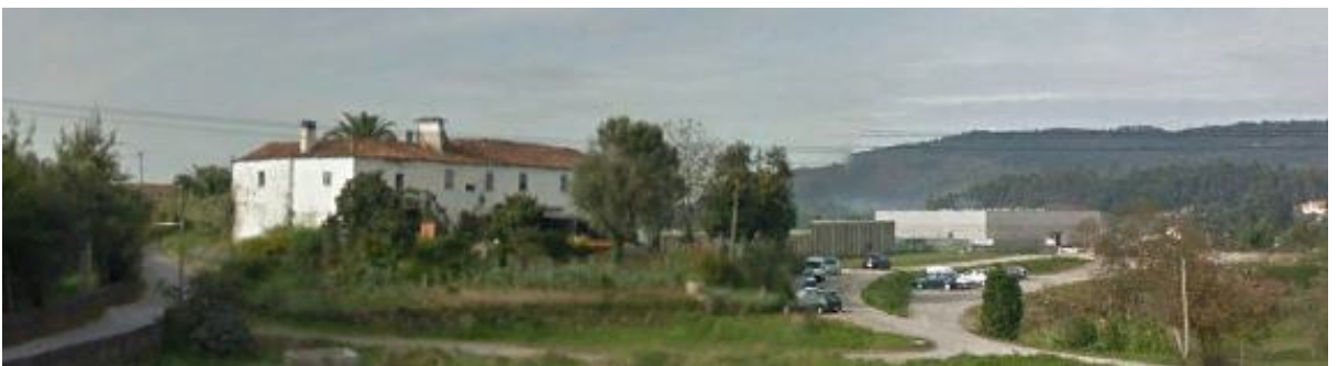
Vista do alçado norte/nascente
