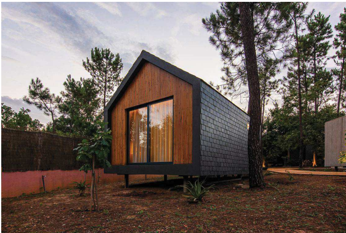
Imagem 2: Imagem tipo do aspeto visual e arquitetura pretendida para as novas unidades a instalar como unidades junto ao solo (Bungalows)
