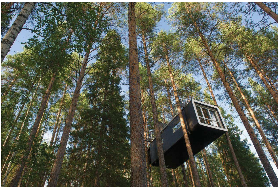
Imagem 1: Imagem tipo do aspeto visual e arquitetura pretendida para as novas unidades a instalar como unidades de árvores (Bungalows)
